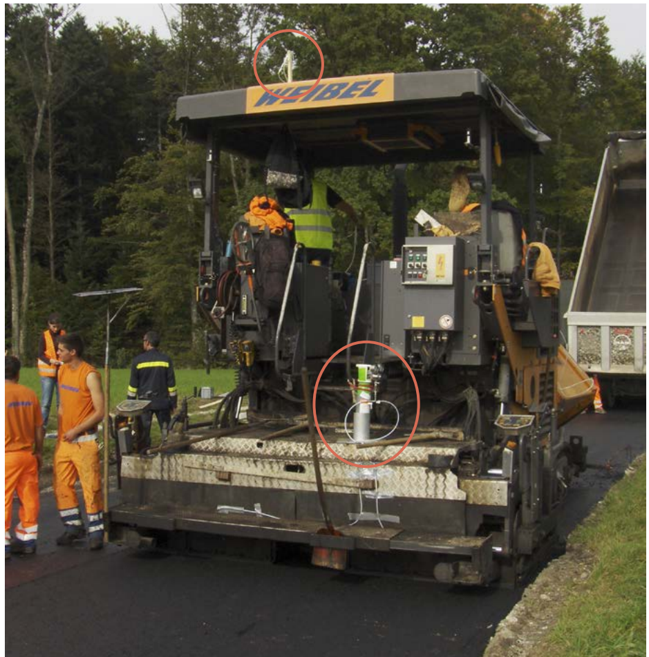
Abbildung 3: Fertiger mit Vorrichtungen für die Bestimmung der Emissionen. Die Arbeiter tragen Probensammler für die Messung der Arbeitsplatzbelastung.
