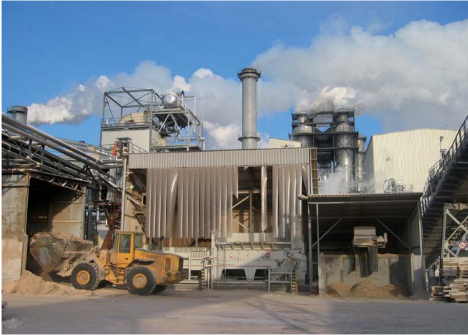
CO 2 -Reduktion: Spanplattenwerk in Russland, dessen Energieversorgung von Schweröl auf Holzabfälle umgestellt wurde.
