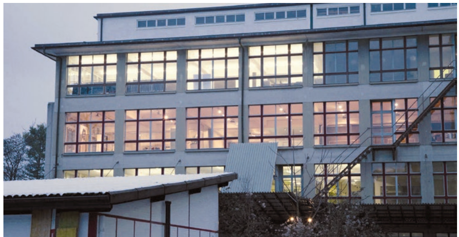
Beleuchtung ist ein auffälliger Energieeinsatz mit Sparpotenzial. Doch in der Haustechnik verbergen sich oft weit grössere Einsparmöglichkeiten.
